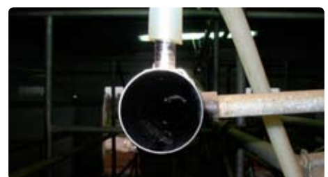
TUBERÍA DE LECHE SUCIA
